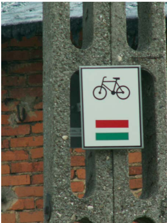
2. Toszek – nieprawidłowo wykonany wspólny znak dla dwóch tras, niezgodnie z wzorem zamieszczonym w projekcie.
