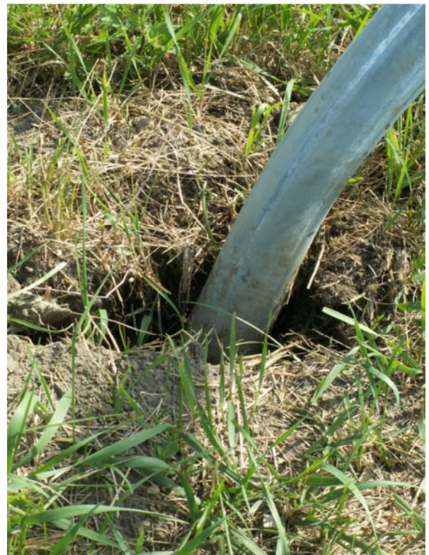
4 i 5. Na trasie nr 389 w pkt. 71 koło Świbia jeden ze słupków nie został prawidłowo umocowany w gruncie. Niezależnie od tego ktoś wygiął słupek i należy go czym prędzej wymienić na nowy
