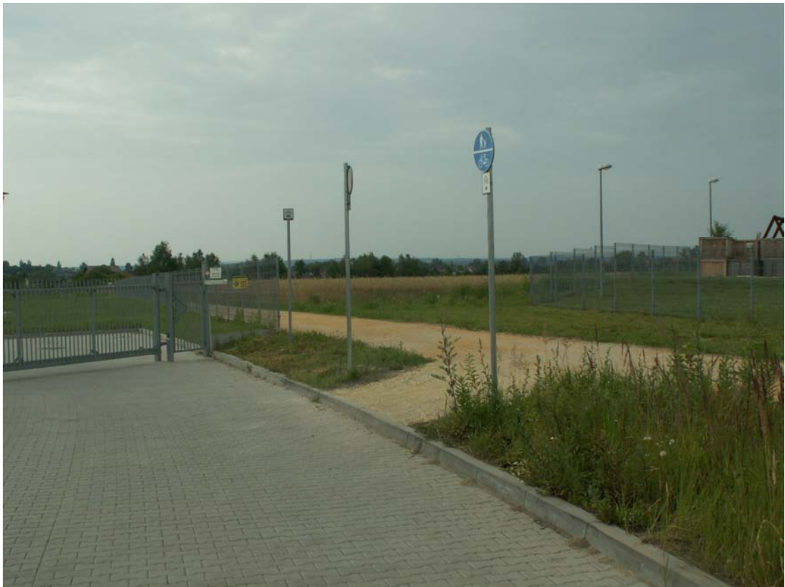
3. Prowizoryczny początek trasy nr 17, w połowie drogi między drogą nr 901 a ul. Traugutta.
